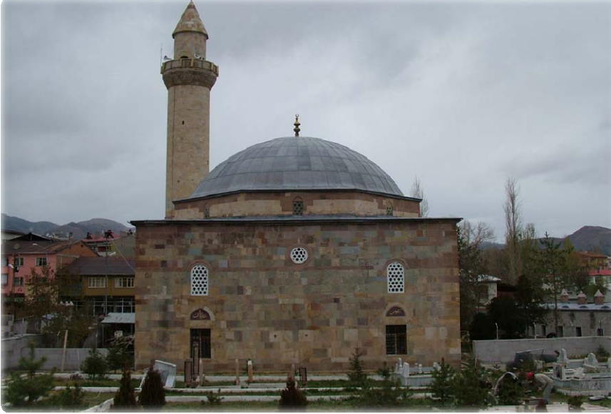
Resim II.- Aslan Paşa Camiinin Güney Cephesinden Görünüşü.
